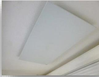
Mise en place de l'installation dans l'espace principal 30 panneaux rayonnants discrets, performants et répartis dans les différentes pièces
